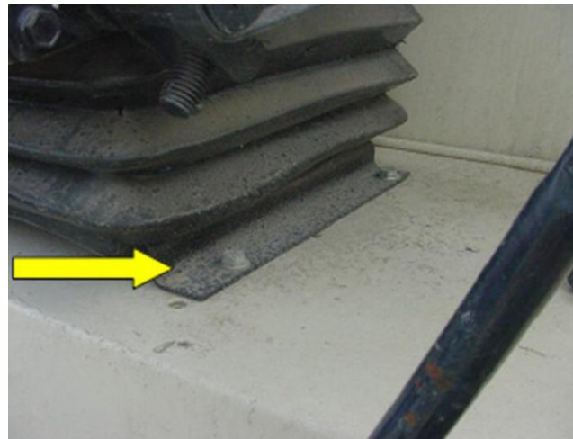
Fig. 78 - bulloni esistenti per il collegamento del sedile
